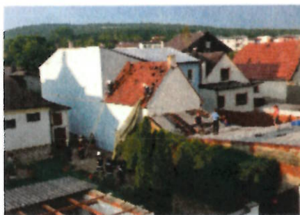
Planen als behelfsmäßige Abdeckung der zerstörten Dächer
