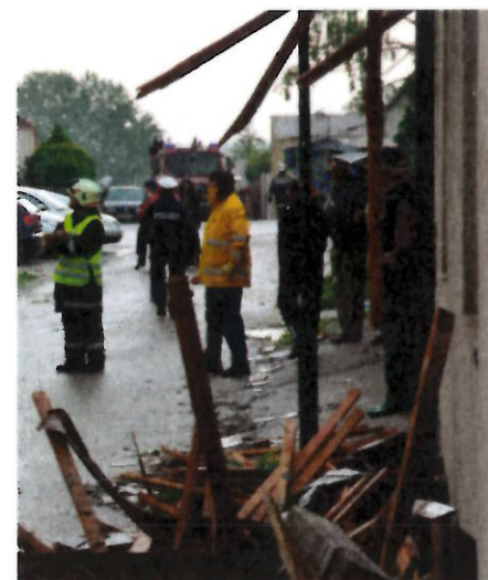
Enorm sind die Schäden an einigen Häusern. Die Stadtfeuerwehr Neufeld unterstützte uns mit der Drehleiter und 12 Feuerwehrmännern.
